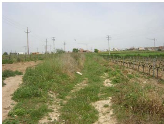
Tram 1: Estat del ferm
