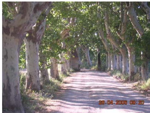
Tram 1: Estat del ferm
