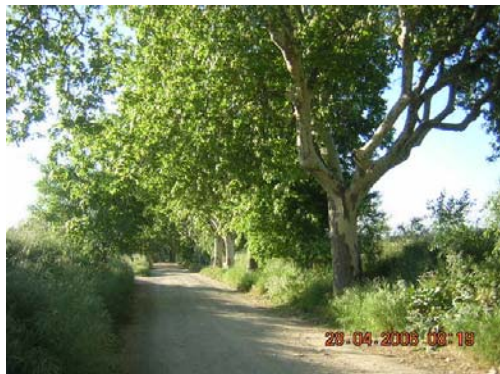
Tram 1: Estat del ferm
