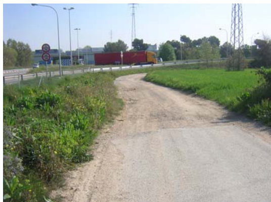
Tram 1: Estat del ferm
