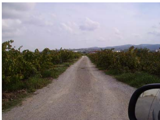
Tram 1: Estat del ferm
