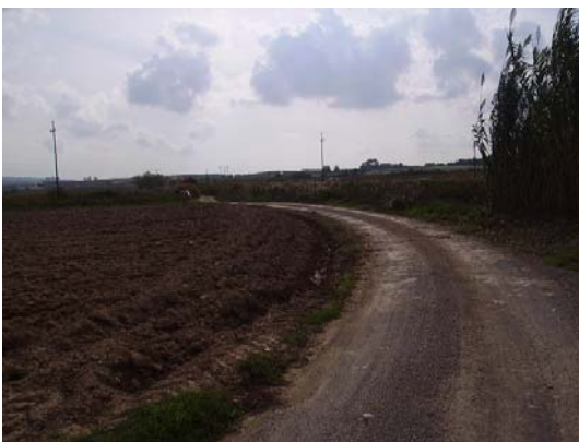
Tram 1: Estat del ferm
