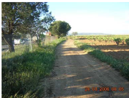
Tram 1: Estat del ferm
