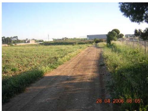
Tram 1: Estat del ferm
