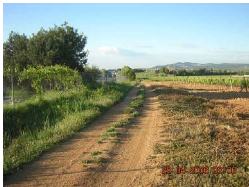
Tram 1: Estat del ferm
