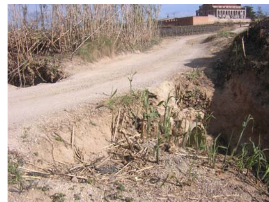
Tram 6: riera de Porroig
