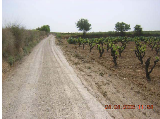
Tram 3: Estat del ferm
