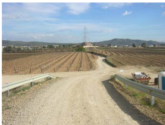
Tram 5: Pont sobre el TGV i RENFE
