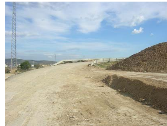
Tram 5: Pont sobre el TGV i RENFE
