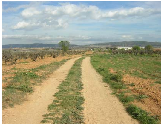
Tram 4: Estat del ferm
