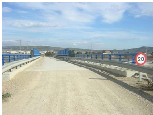
Tram 5: Pont sobre el TGV i RENFE
