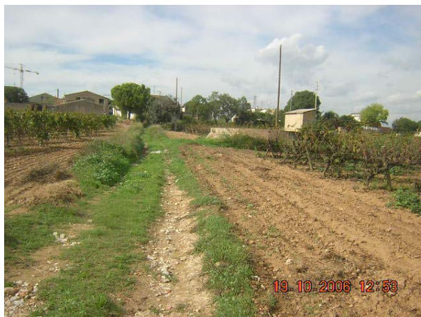
Tram 1: Estat del ferm
