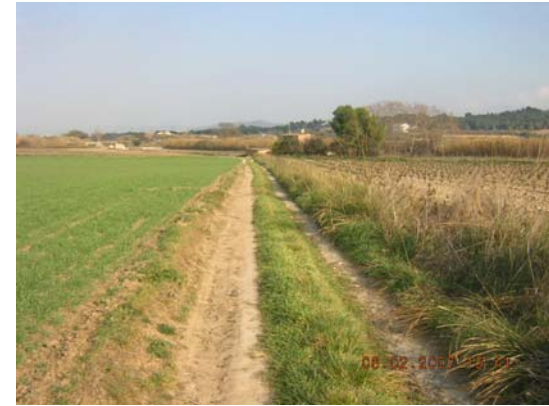
Tram 1: Estat del ferm
