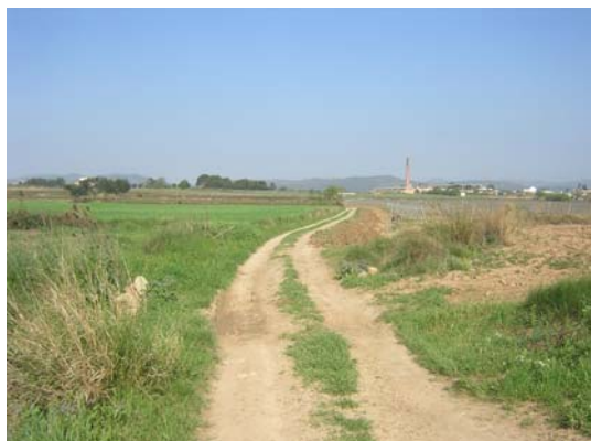
Tram 1: Estat del ferm
