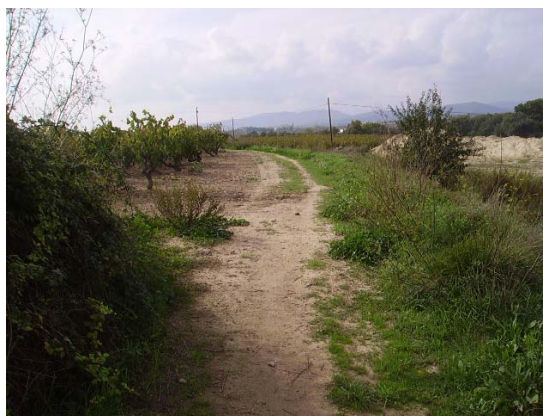
Tram 1: Estat del ferm
